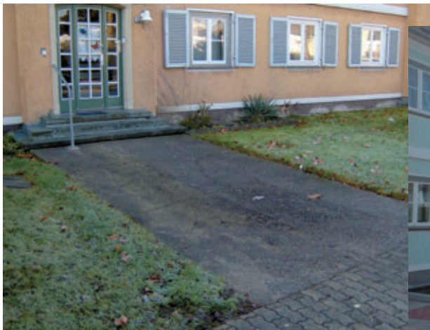
Lindenallee 23-29 vor und nach der Sanierung
