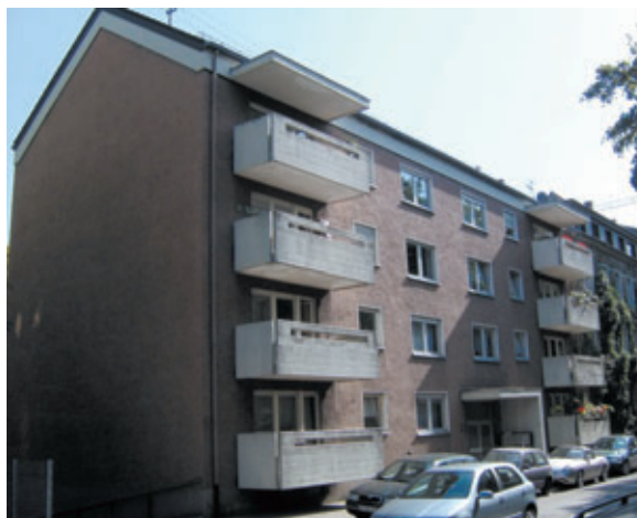
Badener Straße 23 vor und nach der Sanierung
