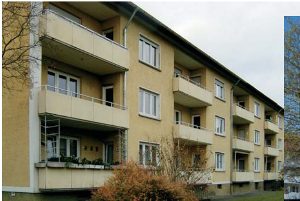
Falterweg 8 - 10 vor und nach der Sanierung
