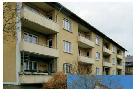
Falterweg 8-10 vor der Sanierung
