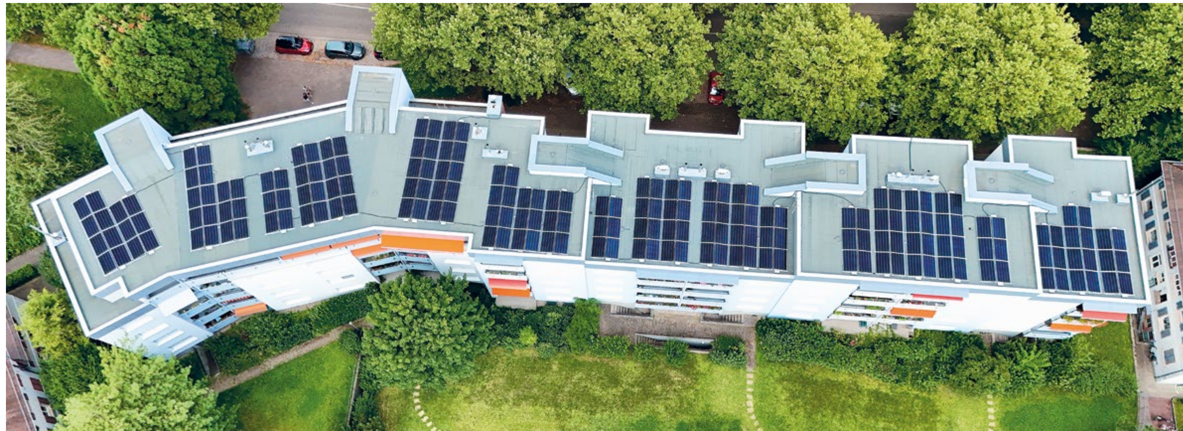
Unsere Photovoltaik-Anlagen auf den Dächern der Rommelstraße 2-10
