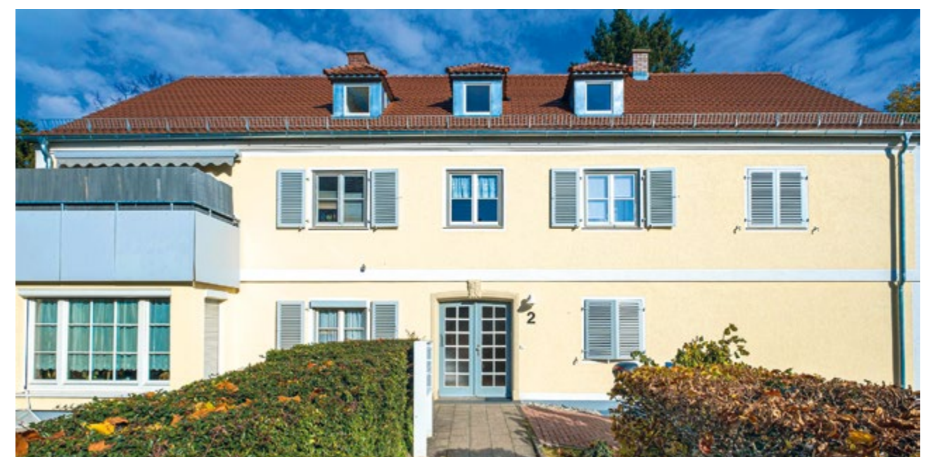
Unser Wohnungsbestand in seinen unterschiedlichen Facetten
