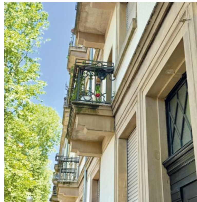
Wohnhaus in der Meidingerstraße
