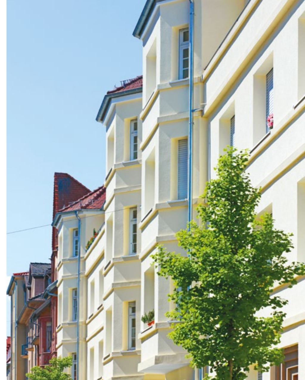
Wohnhaus in der Vorholzstraße
