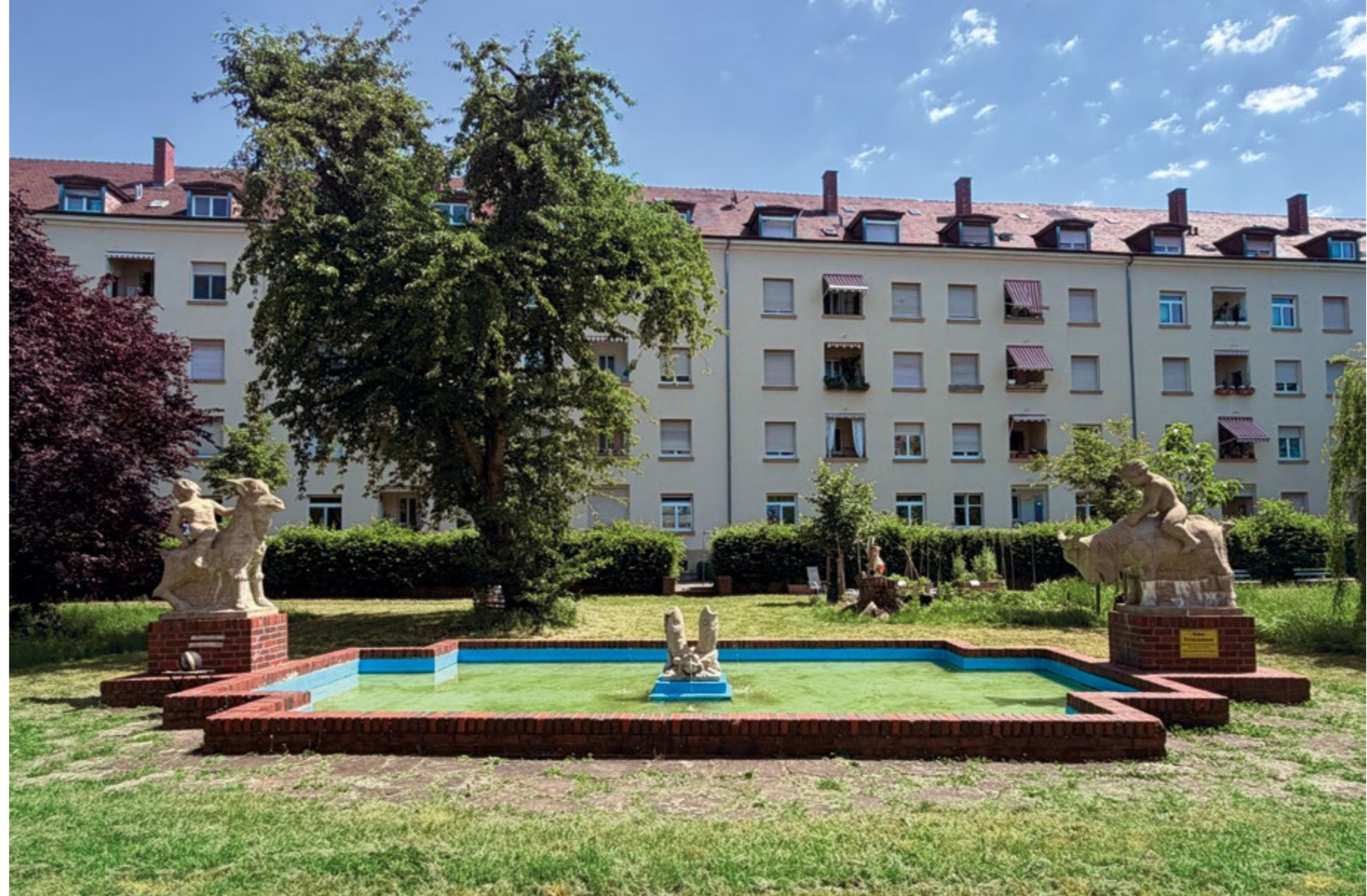
Innenhof des Meidinger Wohnblocks
