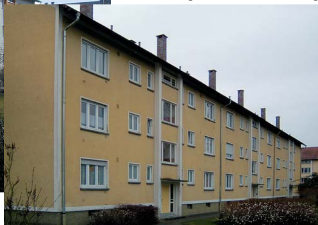
Weidenweg 1-5 vor der Sanierung
