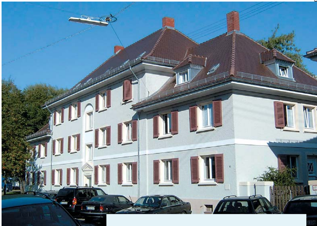
Auer Straße nach der Sanierung
