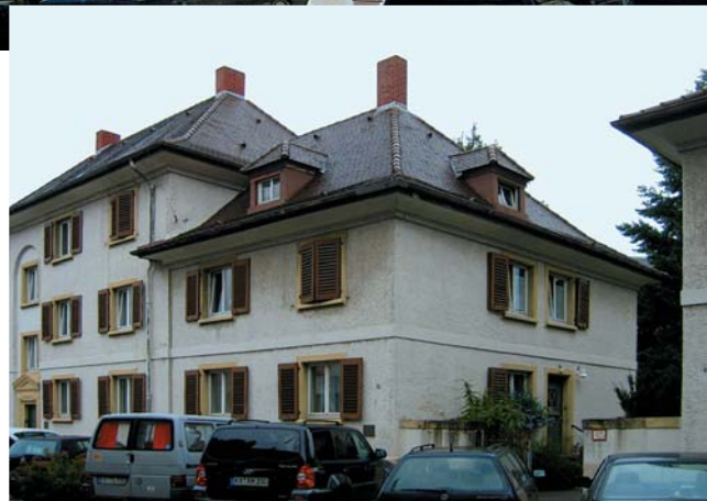
Auer Straße vor der Sanierung
