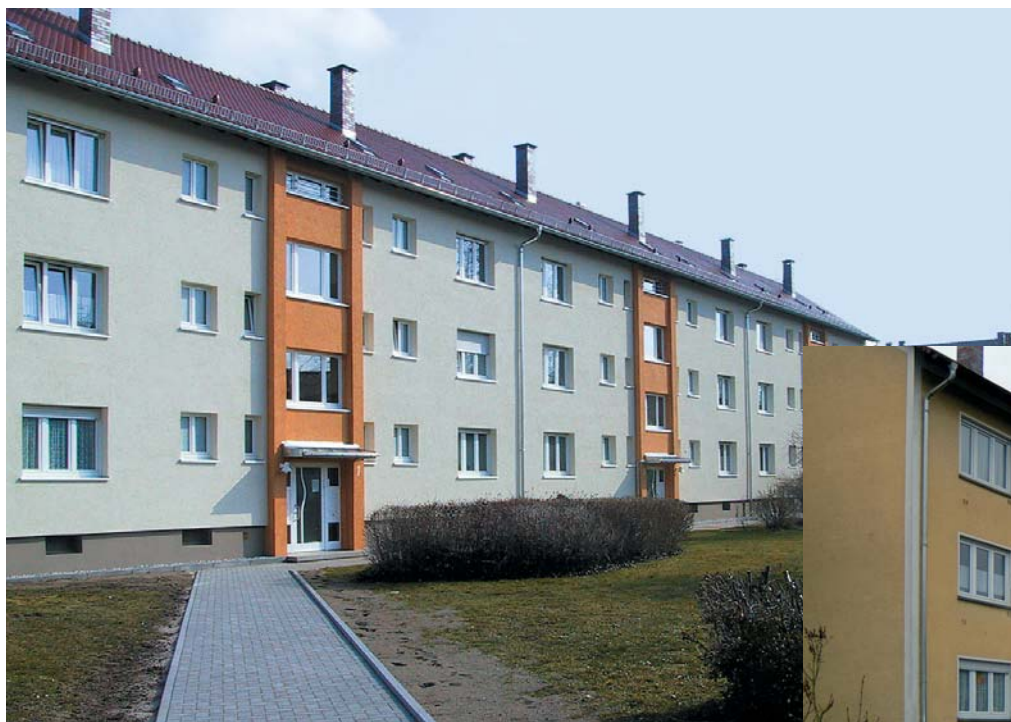
Weidenweg 1-5 nach der Sanierung
